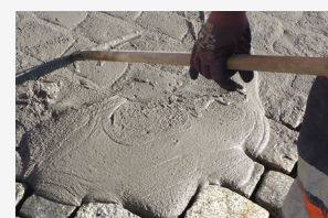
De voegmortel met een rubberen trekker verspreiden.
