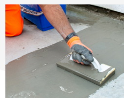
Breng met een borstel tuffbond aan op de ondergrond* en aan de onderkant van de bestratingselementen en plaats direct.
