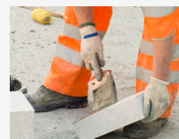
Breng met een borstel tuffbond aan op de ondergrond* en aan de onderkant van de bestratingselementen en plaats direct.
