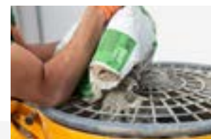
het bindmiddel tuffbed 2-pack toevoegen en mengen met tuffgrit en water
