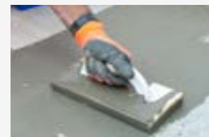
Hechtbrug tuffbond aanbrengen op de ondergrond
